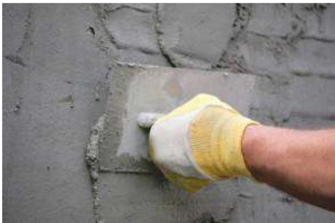
Рисунок 3 - Нанесение штукатурки металлической теркой
