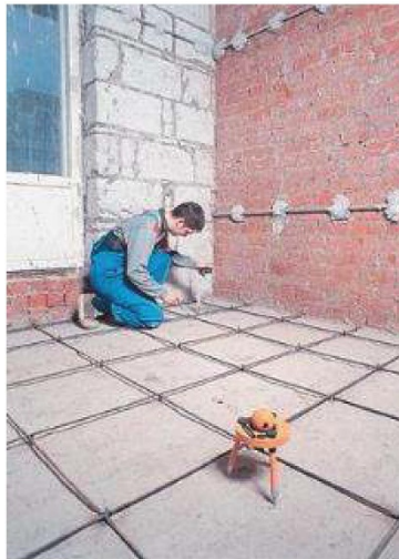
Рисунок 4 - Установка лазерного нивелира
