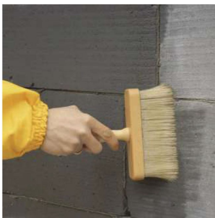
Рисунок 2 - Грунтование поверхности основания кистью
